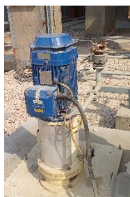
شکل ۶ - الکتروموتور MP-1910 که به صورت عمودی نصب شده است.
